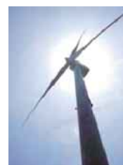
【風力発電機（千葉県銚子市）】
